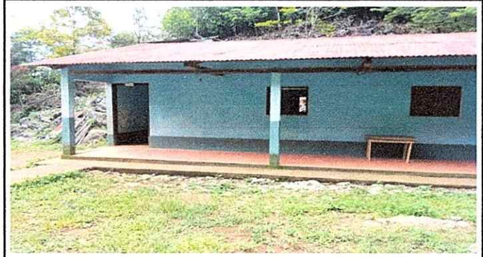
Foto 2: Cambio de entechado de lamina completo
