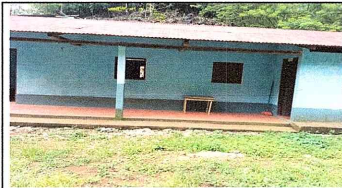
Foto 3: Cambios de puertas del establecimiento y pintar paredes exteriores.
