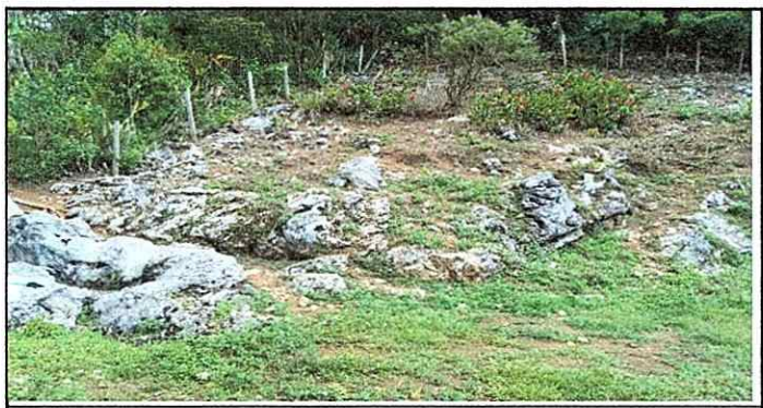
Foto 6: Cambio de cerco de alambre espigado, por cerco de malla
